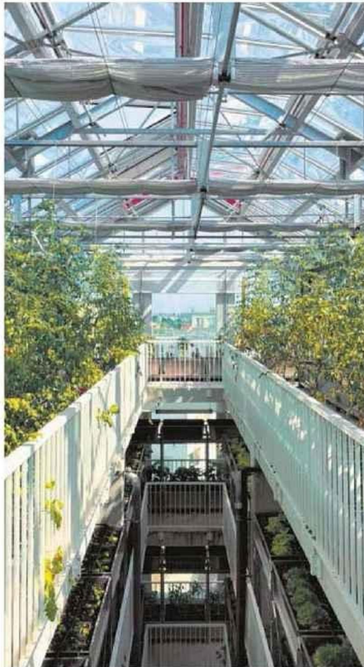
Le bâtiment bioclimatique de la Cité maraîchère abrite des serres recevant pleinement la lumière grâce à un toit et à des façades vitrées – en double vitrage, afin de préserver la chaleur.
