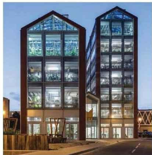
Le bâtiment bioclimatique de la Cité maraîchère abrite des serres recevant pleinement la lumière grâce à un toit et à des façades vitrées – en double vitrage, afin de préserver la chaleur.
